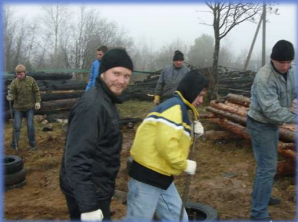
2 ноября 2008. Подготовка места под фундамент приходского дома
